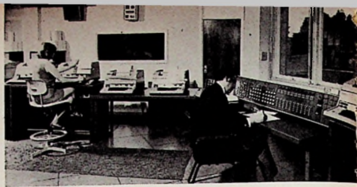
Controleruimte van de SITA-centrale in Londen; rechts de supervisor-post, links naast het druktoetsen-paneeltje de commando-verreschrijver. Foto PTI
